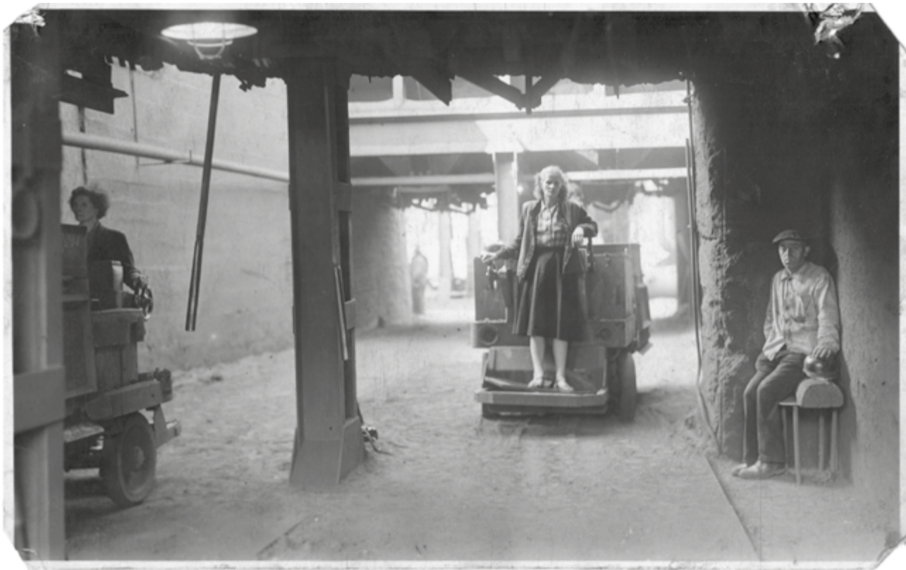
fot. Wielkie piece, prace przy zasiękach wsadowych – transport wsadu wielkopieczowego do windy. Ze zbiorów archiwum zakładowego huty „Pokój”. Dzięki uprzejmości Regionalnego Instytutu Kultury w Katowicach
